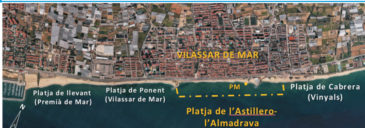
Figura 2. Vista aèria de la platja de Vilassar i el seu entorn, PM=punt de mostreig
